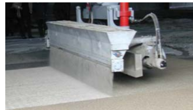
Механизированное нанесение Mapetop N AR6
