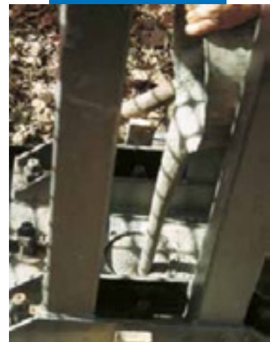
Анкерное крепление с помощью раствора Mapefill
